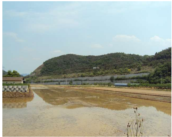
3공구 패널식 옹벽 02
