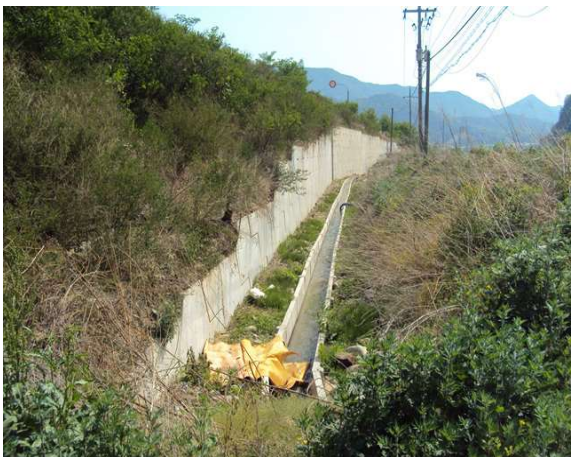
7공구 패널식 옹벽 11
