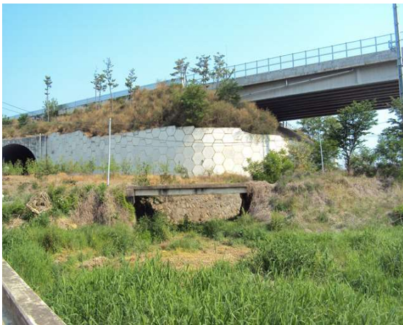
9공구 패널식 옹벽 15
