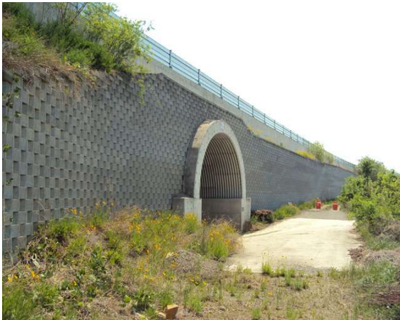
6공구 블럭식 옹벽9
