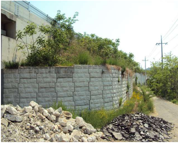
6공구 패널식 옹벽 07
