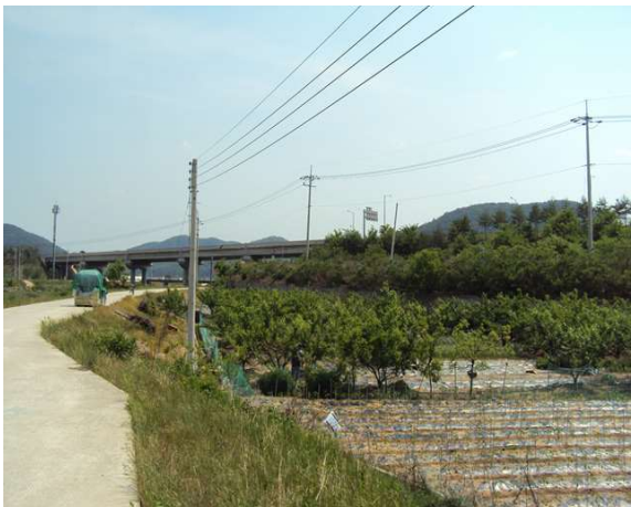
4공구 블럭식 옹벽 03
