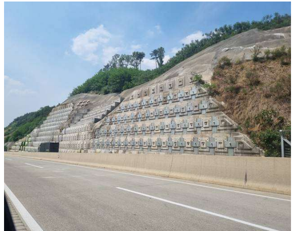
6공구 패널식 옹벽 10
