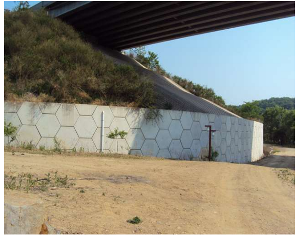
9공구 패널식 옹벽 14
