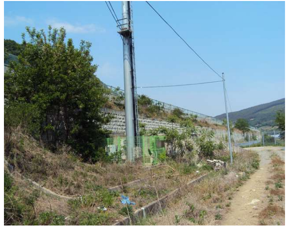
6공구 패널식 옹벽 08
