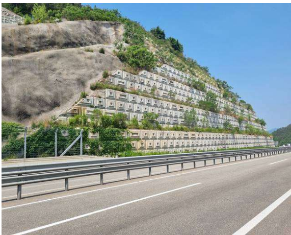
4공구 패널식 옹벽 05
