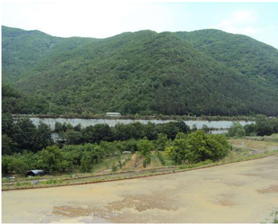
3공구 패널식 옹벽 01
