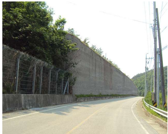
4공구 블럭식 옹벽 04
