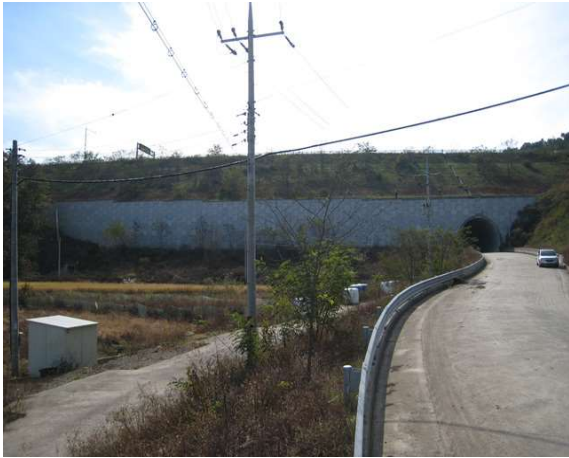
8공구 패널식 옹벽 13
