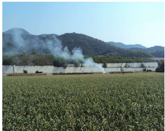
7공구 패널식 옹벽 12
