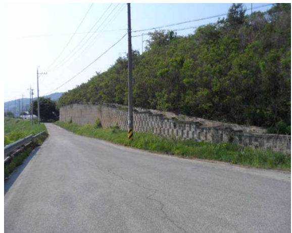
5공구 블럭식 옹벽 06
